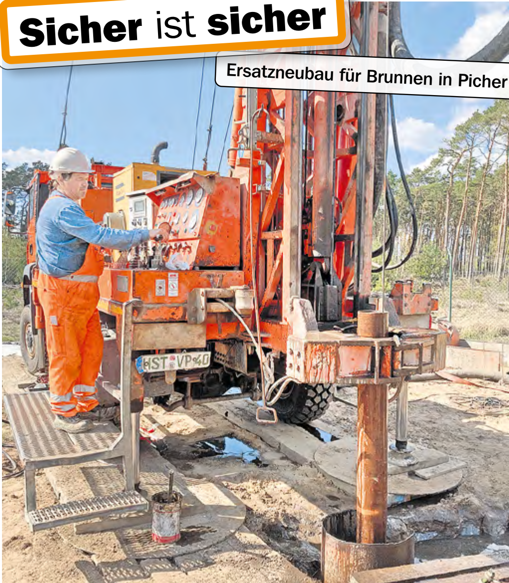
Die Brunnenbauer haben die schwere Technik gut im Griff und sorgen so für den richtigen Weg in die Tiefe.
