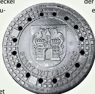
der Wasserfachmann als „Kanaldeckel“ eine Abdeckung beispielsweise eines Wartungsschachtes oder eines größeren Abwasserschachtes. Dieser ist meistens rund und breiter. Der Durchmesser beträgt 61,5 Zentimeter. Für die runde Form
