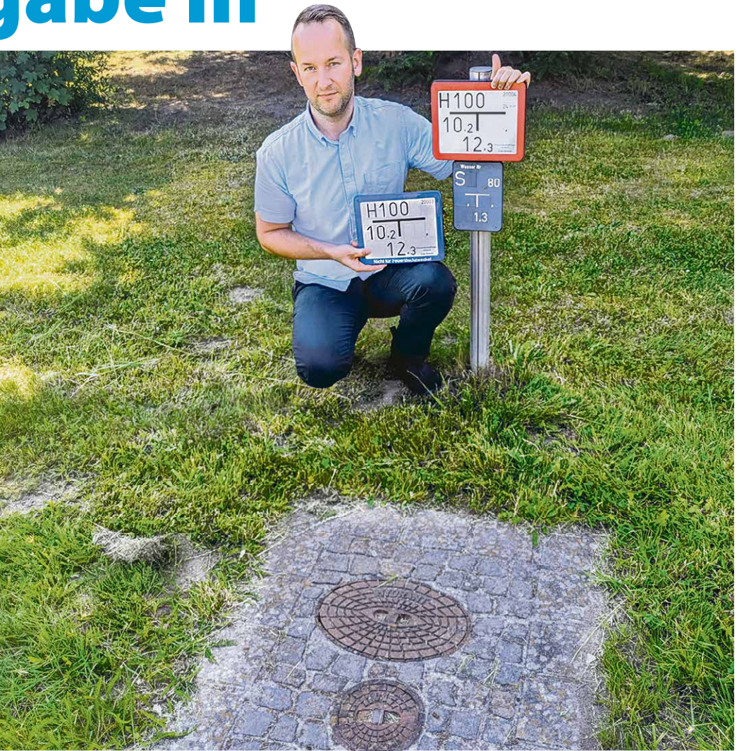
Thomas Wirth verdeutlicht: Bisher war nur ein Schild im Umlauf. Jetzt unterscheidet ein blauer oder roter Rand über den Einsatz des Hydranten für Trink- oder Löschwasser.
